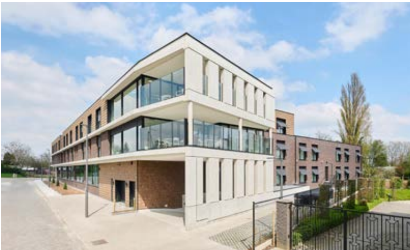
► Woonzorgcentrum Villa Batavia - Grimbergen (BE)
