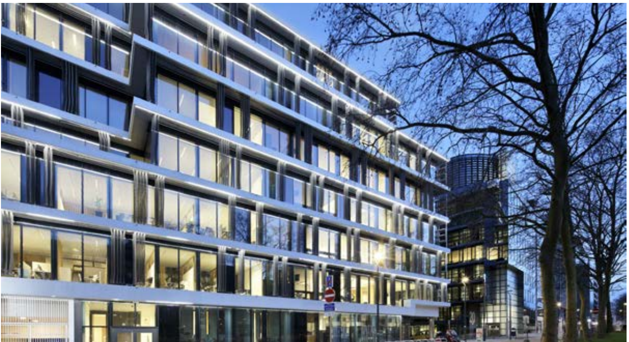
► Kantoorgebouw Quartz – Brussel CBD (BE)
